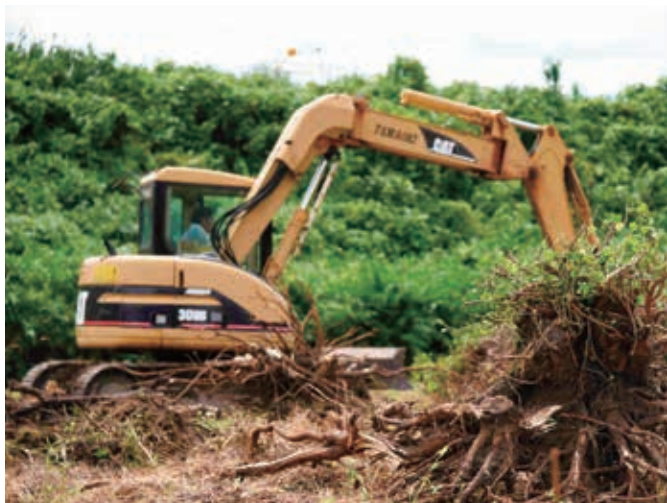
柿の切り株を重機で掘り起こす(2021年8月)
