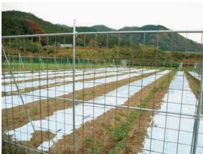
いちじく畑の周囲は、ワイヤーメッシュと鉄パイプで防獣柵を自作した(2021年11月)
